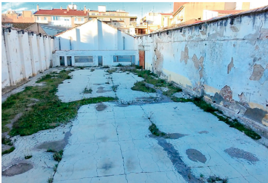
Imatge de l'interior de l'aparcament del carrer Clerch i Nicolau
